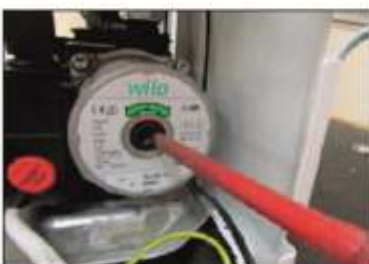
1. Откройте лицевую панель для доступа к насосу
