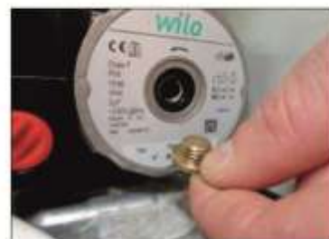
3. Дайте оставшейся воде вытечь, подставив при этом под нее соответствующую емкость
